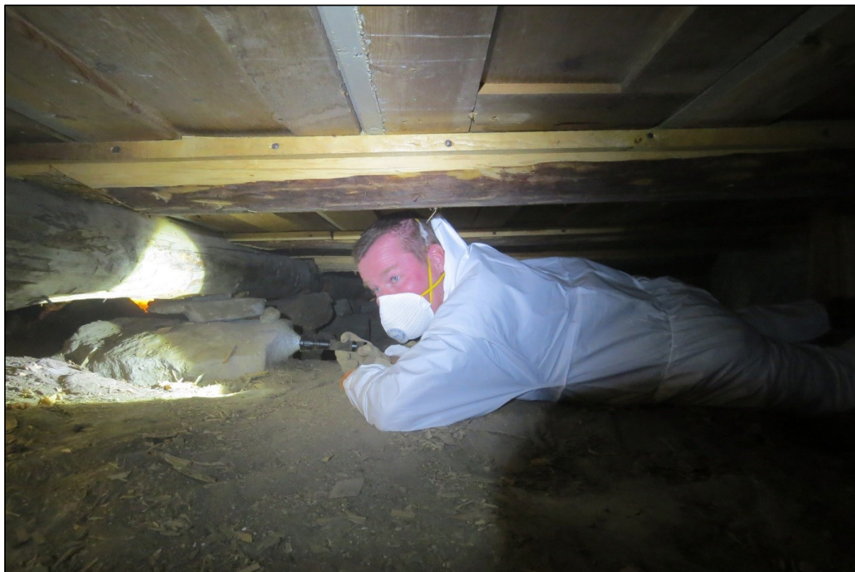
Figur 6. Ola George under kyrkgolvet vid besiktningen.
