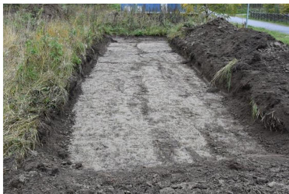
Figur 20. Schakt på område 4, från öster.
