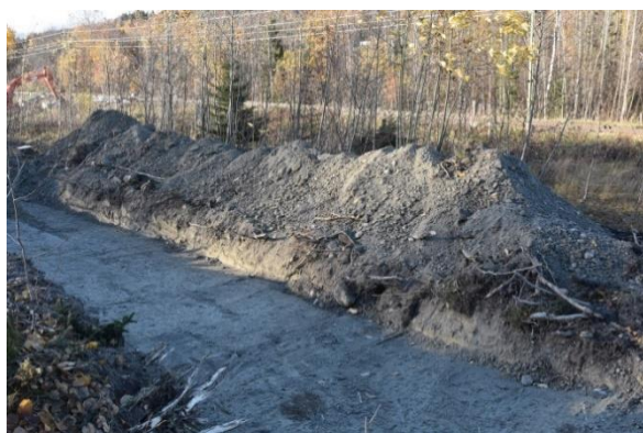
Figur 21. Schakt på område 2, från sydost.
