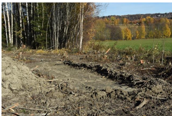
Figur 19. Schakt på område 3, från sydost.
