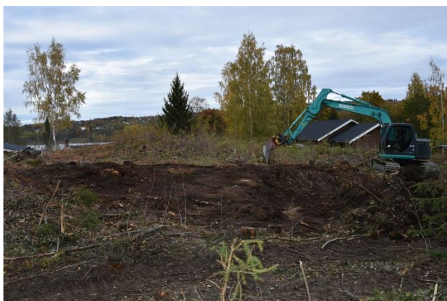
Figur 8. Grävmaskinisten Erik Bergman torvar av området kring Raä 45, från väster.
