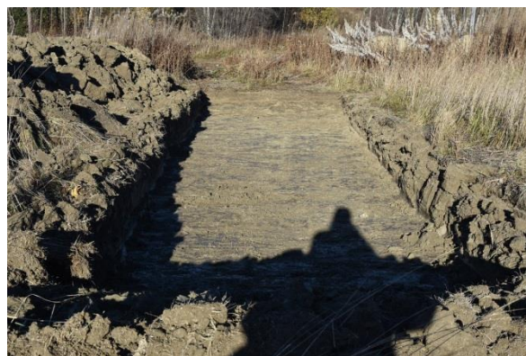
Figur 22. Schakt på område 1, från söder.
