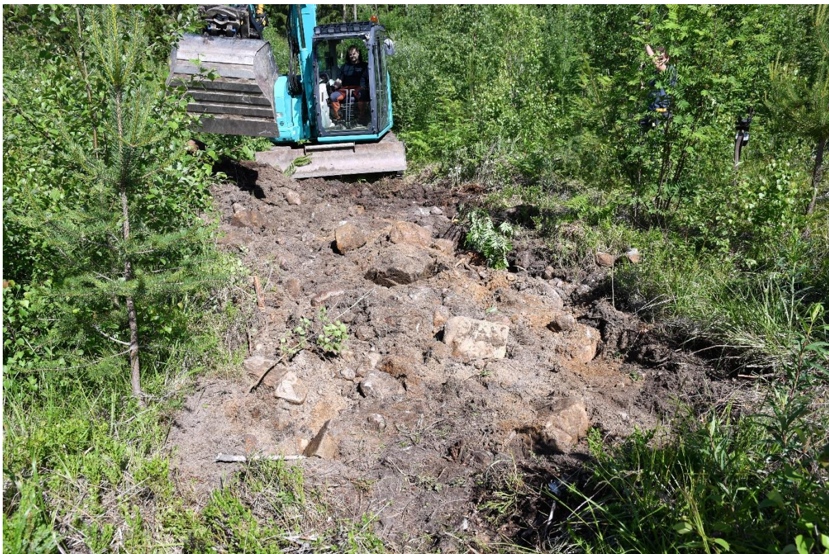
Figur 10. Schakt 16 från sydöst.
