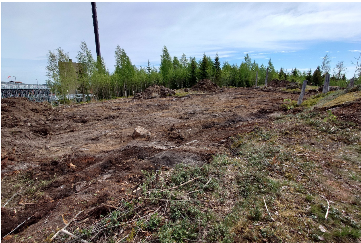
Figur 5. Schakt 1, södra området. Foto från väster.
