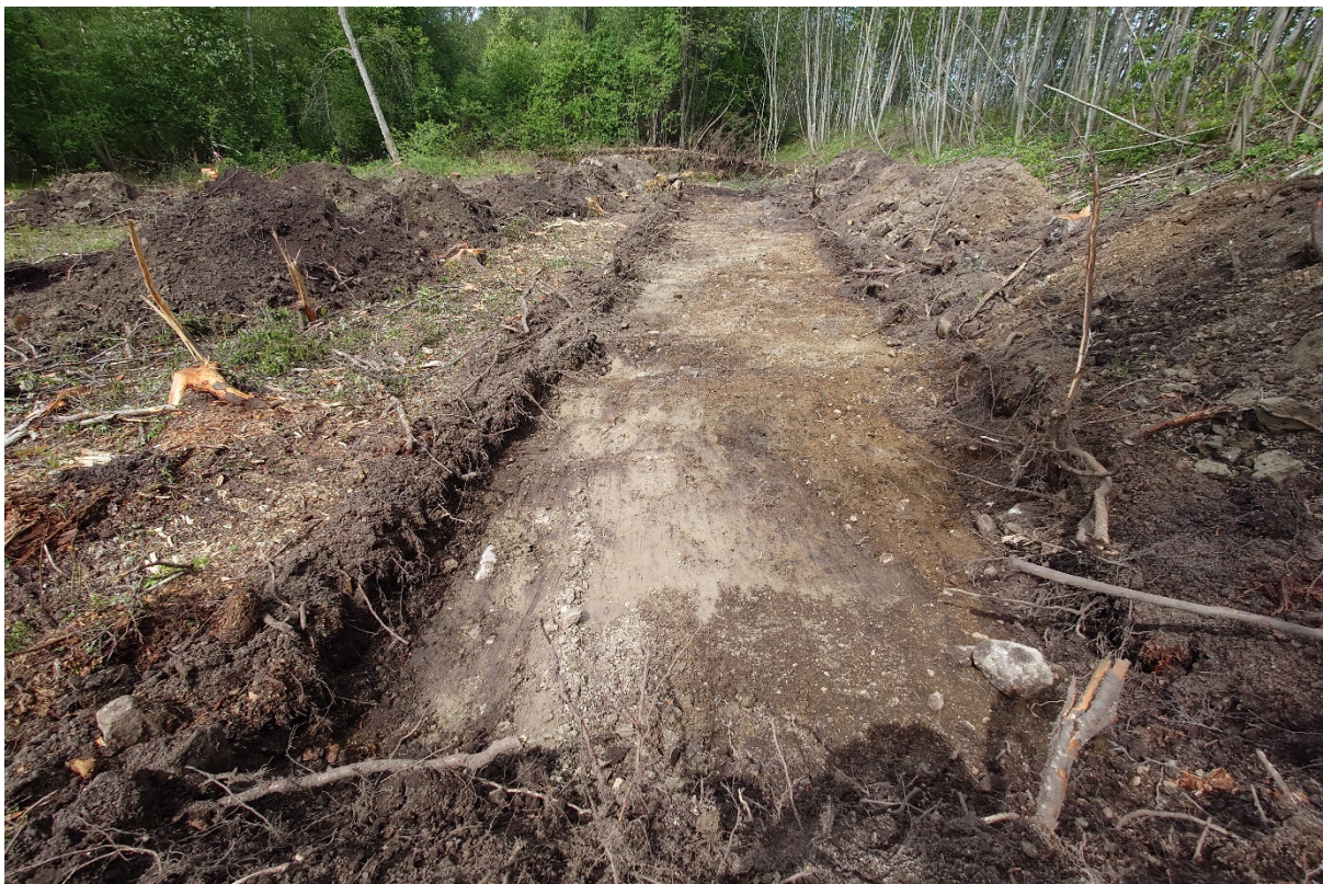
Figur 18. Schakt 15 norr om Korstabergsvägen. Foto från sydost.
