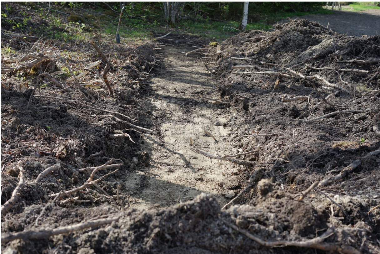
Figur 11. Schakt 10 från öster.
