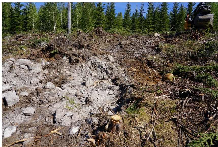
Figur 7. Schakt 6. Foto från syd.
