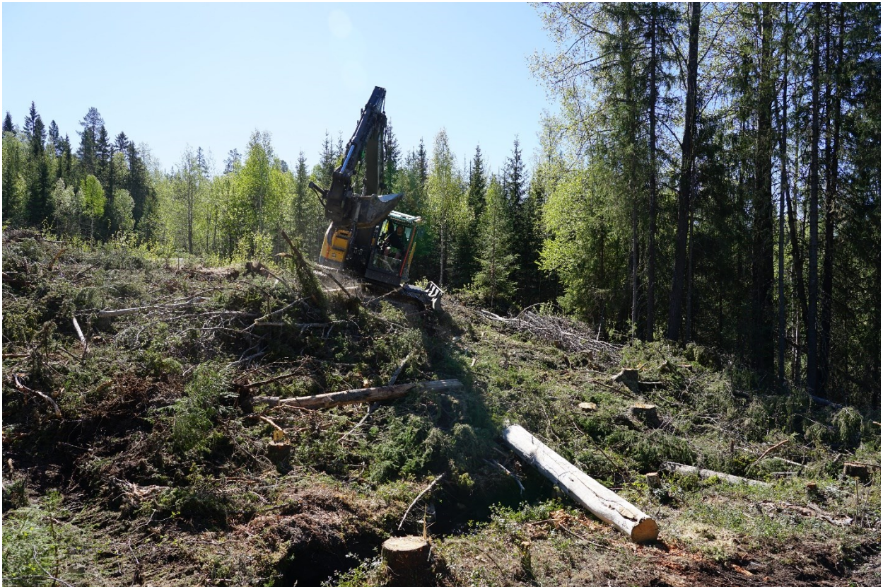
Figur 12. För sista schaktet behövde grävmaskinen avlägsna ris och timmer från marken med hjälp av skopans klo. Foto från nordväst.
