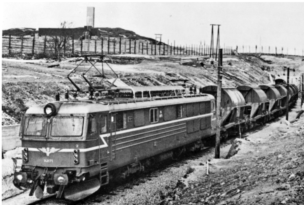
Kistoget fra Tverrfjellet på tur ut fra jernbanestollen på sidesporet mot Hjerkinns stasjon.
