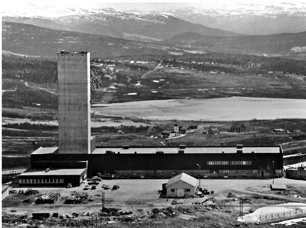
Nyanlegget på Tverrfjellet. Fotografert ovafra, nedover Folldal i bakgrunnen, trolig i forbindelse med offisiell åpning av anlegget 12. juni 1969. Foto Per Magne Grue / Østlendingen. Musea i Nord-Østerdalen, nr. 108410.
