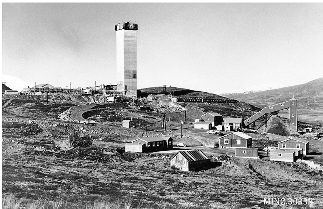
Nyanlegget under bygging. Øverst i loddsjakttårnet ses glideforskalinga som vart brukt under bygginga av dette. Bygningene ellers er satt opp fra omkring 1960: Skråsjakttårnet med sjakthuset som også inneholdt lager, kvilerom og kontor, samt flere brakker. Helt fremst et eldre seterfjøs. Foto: Ola Nyeggen, 1966. Musea i Nord-Østerdalen, nr. 30338.
