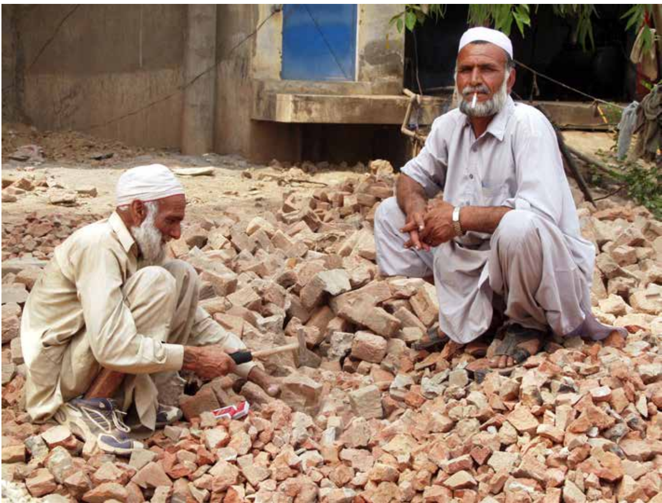
HUGGING AV STEIN TIL VEIARBEID.
