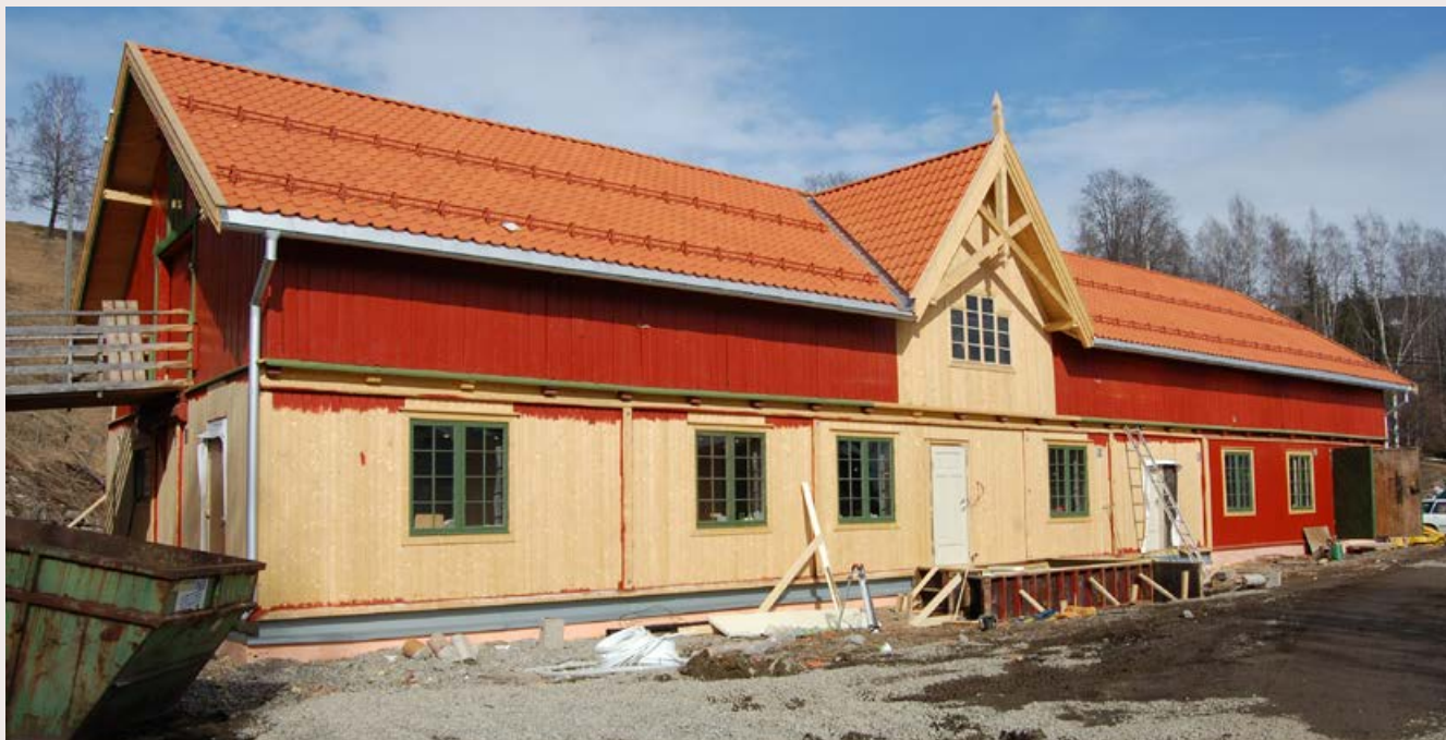
Tilstandsgrad 1 – taket er nylagt, panel er skiftet og nymalt. Foto Kjell Marius Mathisen
