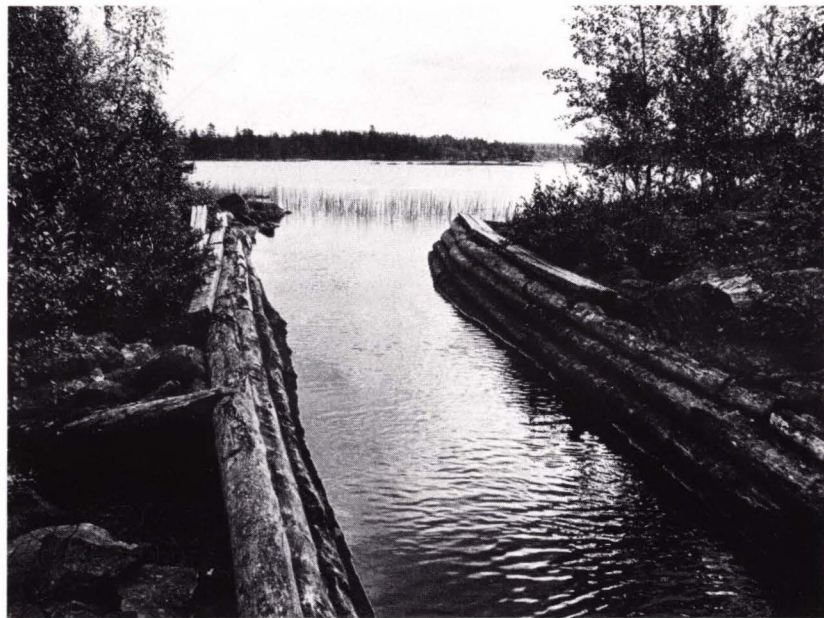
Kanalinntaket fra Kalven i Femund. Kanalen var ca. 2 m bred slik at varpebåten fikk plass. Foto: T. F.
