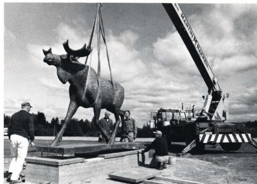
Elgoksen løftes på plass på sokkelen. I bakgrunnen Håkon Sæle og Skule Waksvik. Foto: O. T. L.
