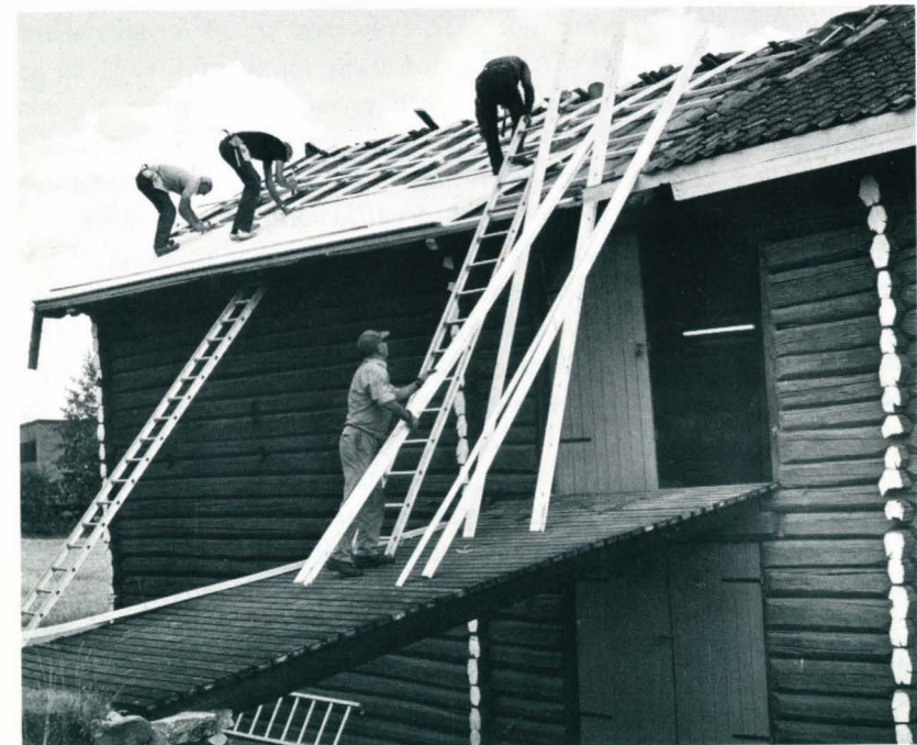
Omlegging av taket på Klokkergårdslåven.
