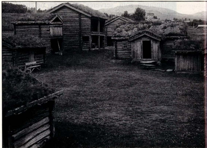
Nordre Husan fra inne i gardstunet. 1991.
