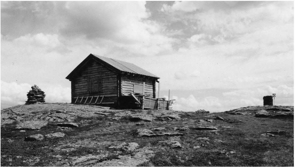
Vakthytta på Ledsageren, under restaurering.
