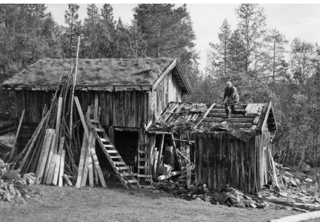
Nytt tak på vedskjulet, Leif Haugrud gjør arbeidet.
