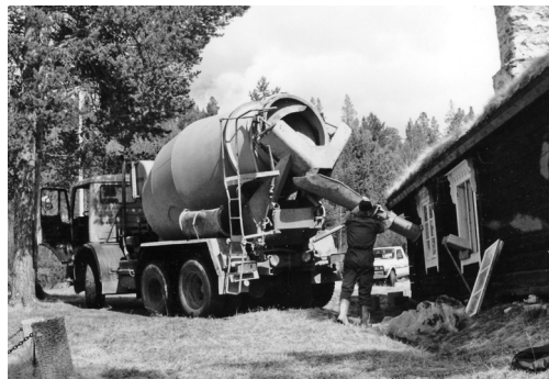
Støping av såle under Gammelstua i 1991
