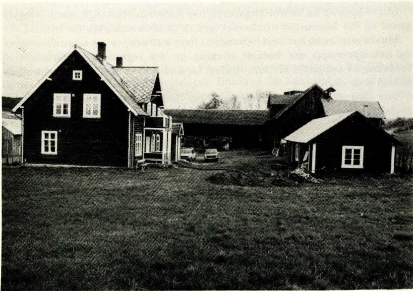
Ramsmoen-museumssenter for Nord Østerdalen - hovedbygningen, eldhuset (t.h.) verksted, fjøset i bakgrunnen skal bli utstillingslokaler, stallen t.h. skal vike plass for fremtidig brannsikkert bygg. Sentral beliggenhet med Rådhuset som nabo.
