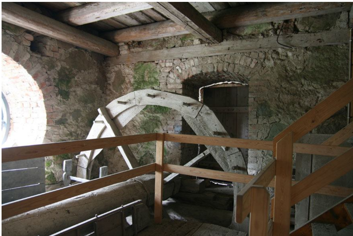
I tornet finns denna konstruktion med ett trähjul kopplat till en stock som har fungerat som uppfodringsverk vid byggandet av tornet eller för att forsla upp kyrkklockorna.
