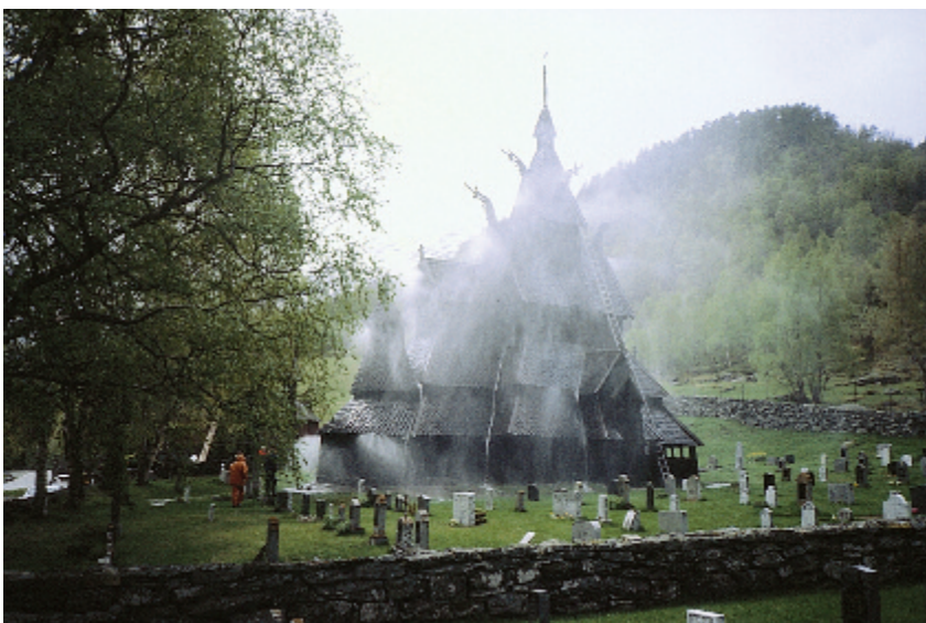
Borgund stavkirke har blant annet overrislingsanlegg. Dette er effektivt for å slokke utvendige branner. Bildet viser hva som skjer når anlegget blir utløst. Dramatikken i situasjonen understrekes av at det samtidig utløses en alarm som kan høres i vid omkrets. Foto: Nils Marstein, Riksantikvaren.
