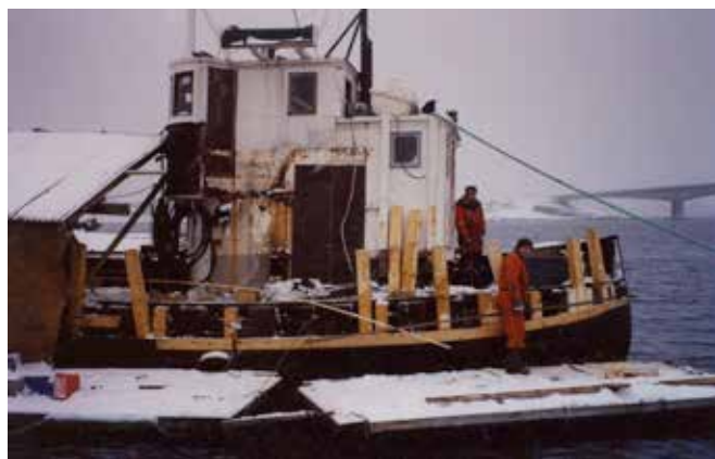
Utskifting av rekkestøtter, hudplank og skandekkk hos Ansnes Båtbyggeri, foto: Willy Eide
