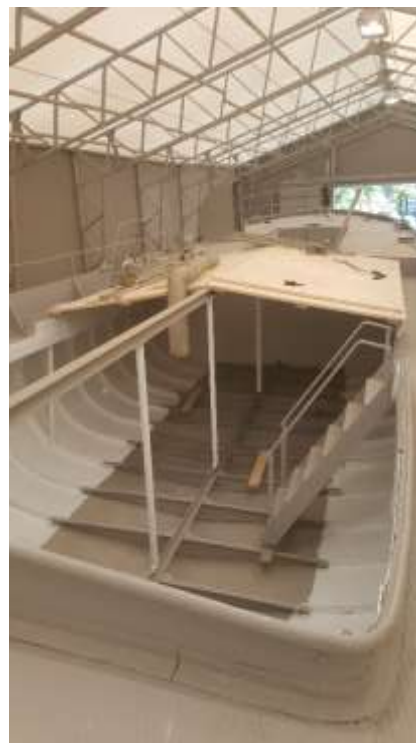
Ferdig sandblåst, primet og påbegynt toppstrøk. Dekksluker delvis lagt.
