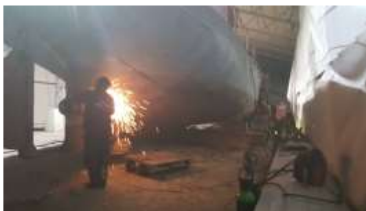
Sveising av groprust og sliping
