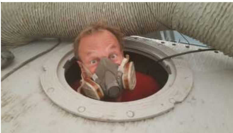
Overflatebehandling i aktertanken. Maske og avsug nødvendig HMS.
