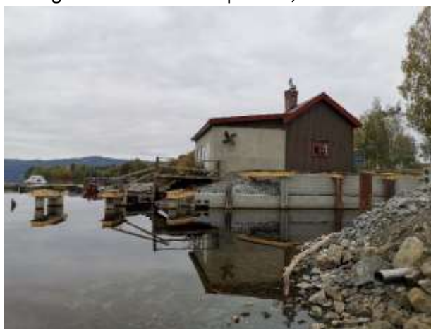
Havneanlegget underveis, bygningen i bakgrunnen er tidl. fløtningssmie. Dette vil bli en fin formidlingsarena og et funksjonelt lokale for videre arbeid og aktiviteter.
