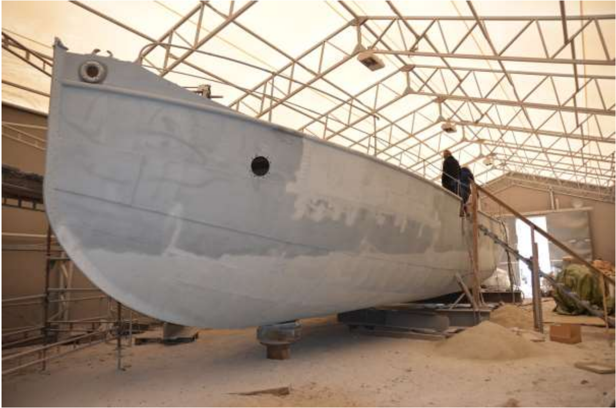
Overflatebehandling etter ferdigstillelsen av stålarbeid (casing og lysventiler gjenstod)
