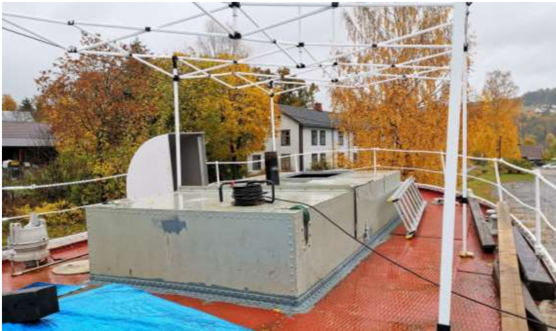
Casing ferdig klinket etter litt justering. Våt høst uten arbeidshall.
