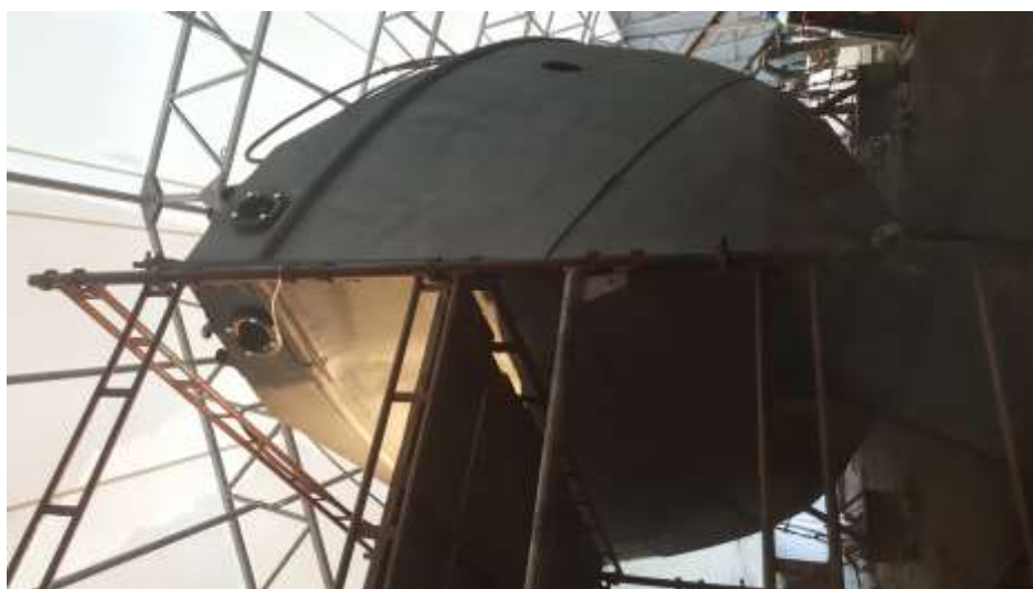
Ankerklyss ferdig montert
