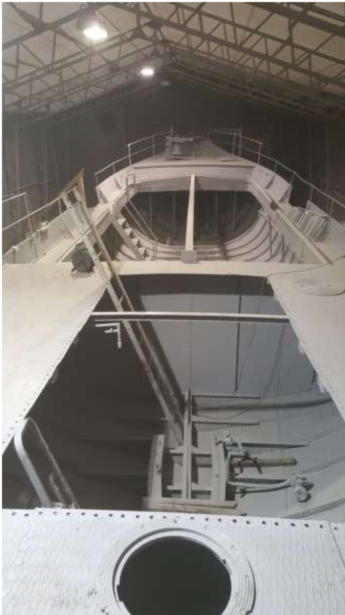
Ferdig sandblåst, primet og rengjort før maling
