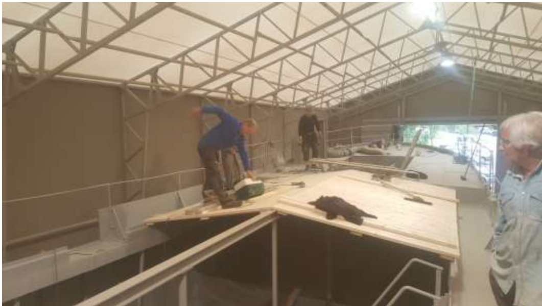
Dekksluker og rengjøring
