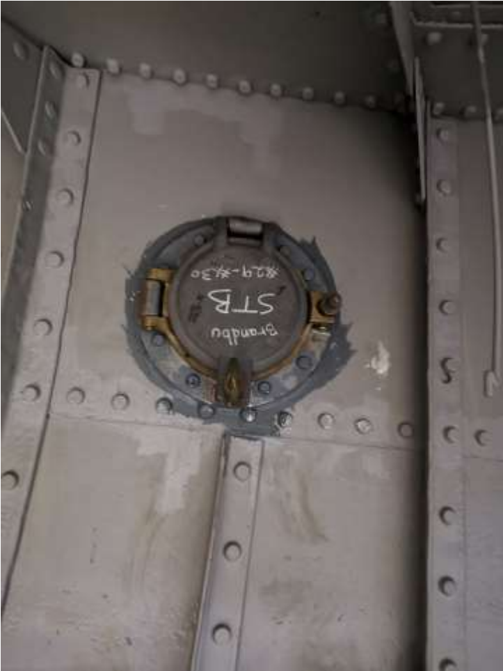
Nye lysventiler ferdig innfestet
