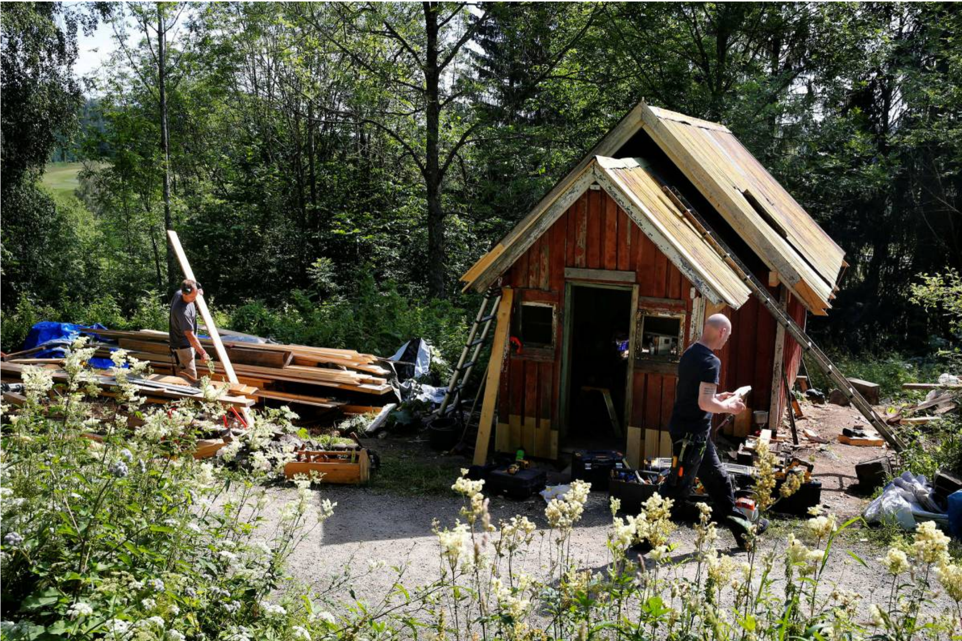
Gamle Saghytta på Ankerveien restaureres. I løpet av august blir trolig bygget fra slutten av 1800-tallet ferdig. David Hyden og Geir Jacobsen Fruseth står for arbei...
