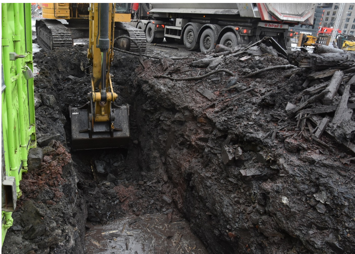
Figur 8: Graving av vestsputen med vannfylt grøft. De store mengder treverk i massene stammer fra konstruksjoner antatt å datere hovedsakelig til 1800-tallet.
