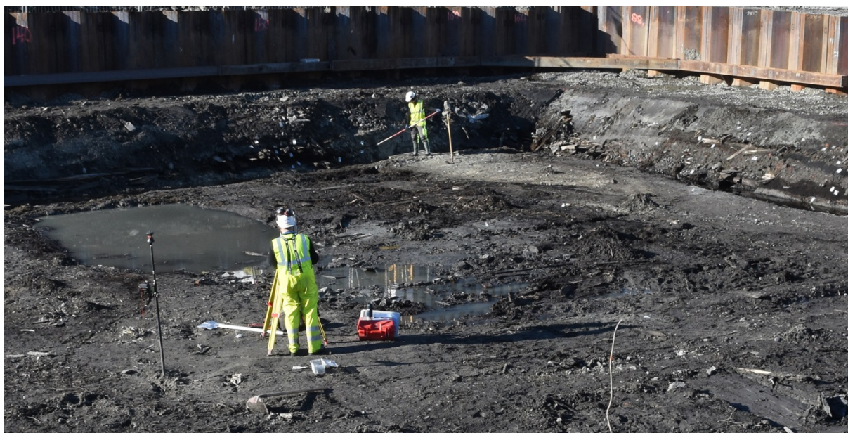
Figur 7: Innmåling av profil 2 med totalstasjon
