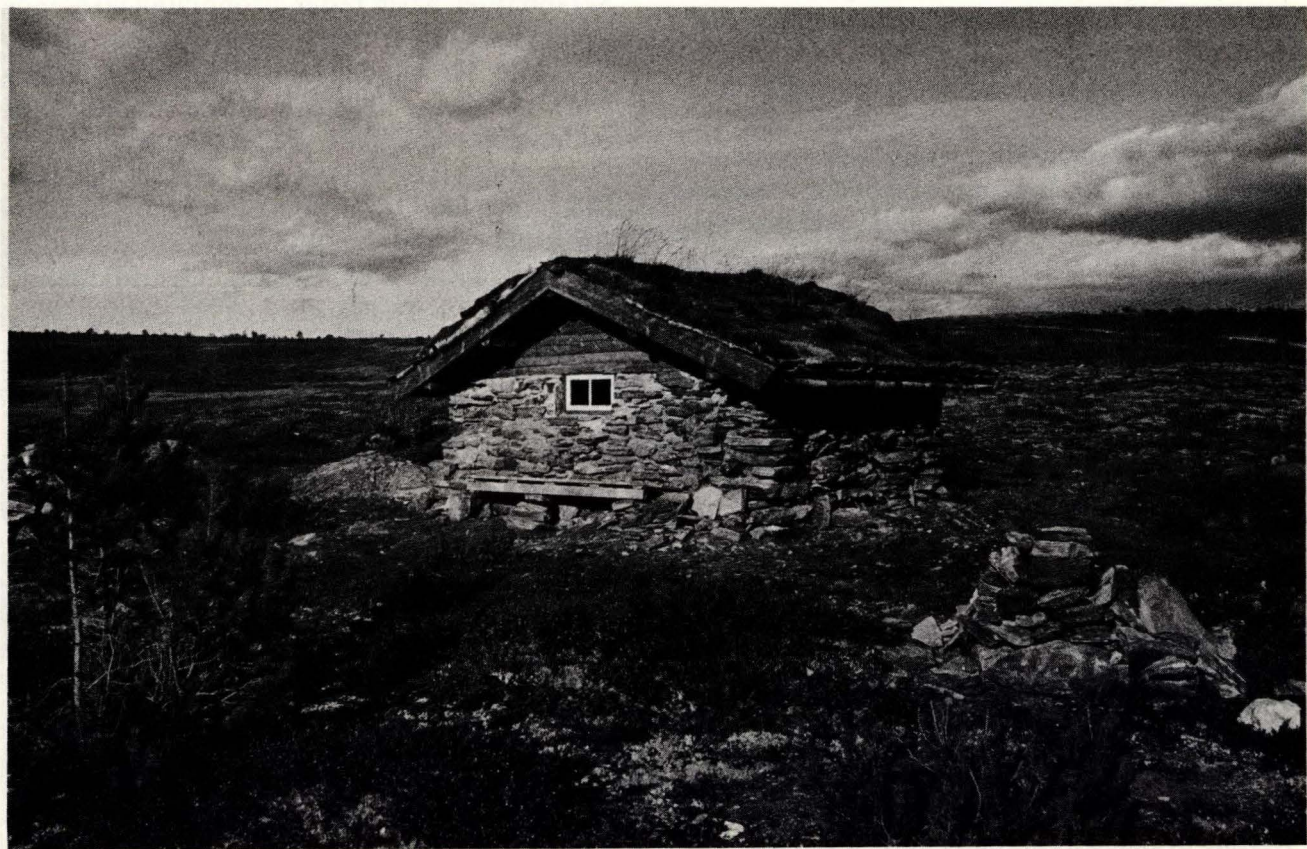
Skrabbhuset ferdig restaurert
