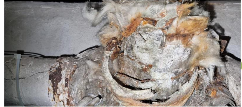
Bilde 3 – Rørbend er et vanlig sted for å finne asbestholdig tetningsmasse. Bilde er tatt i tankrom i kjelleren.
