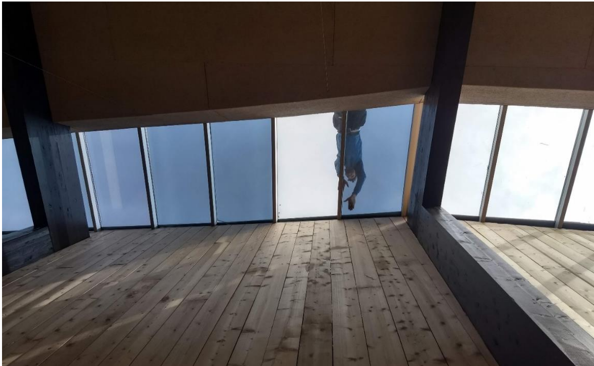
Montering av folie for å redusere UV, lux og varme i utstillingslokala i Velkomstbygget. Foto: Valdresmusea.
