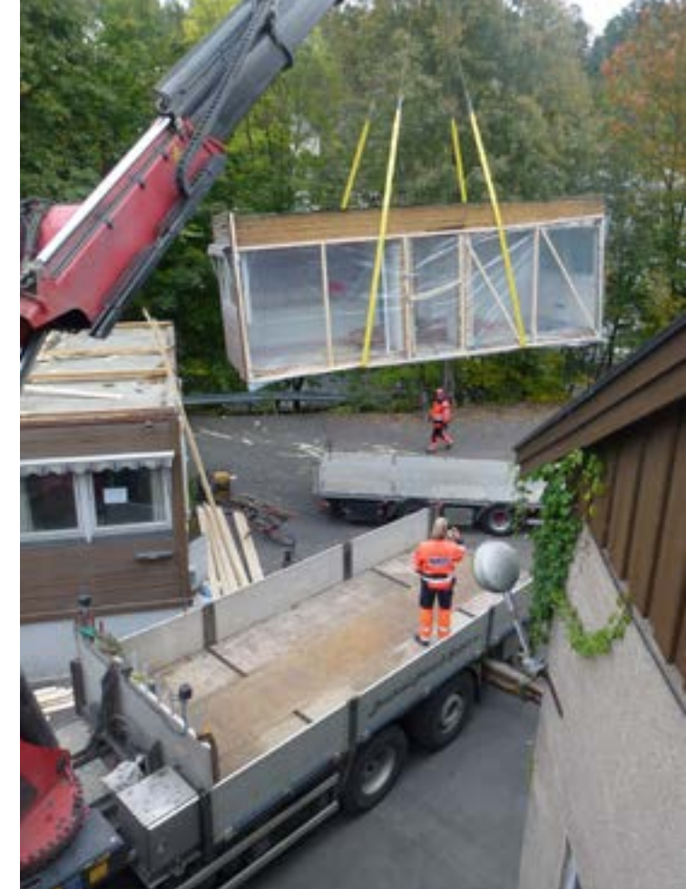
Flytting av brakker fra Sandvika til Hunderfossen høsten 2013. (Foto: Morten Lund)
