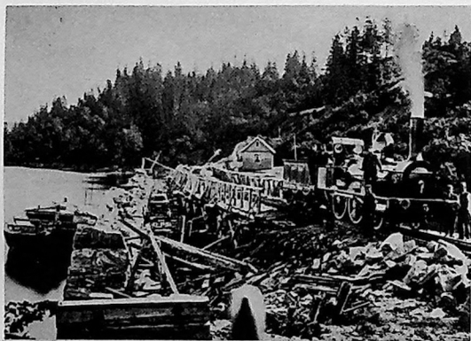
Bilde fra anlegget Legg merke til trebroen. Opprinnelig var bare broen over Akerselven og over Leirelven av jern.
