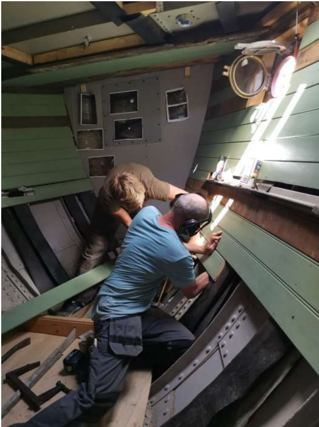
Innfesting av bord SB. Morten fikk med seg en hjelpemann, Theodor J. Brynie (15) i arbeidet. Uvurderlig med en hånd ekstra og en fin introduksjon til kulturminnevern og restaureringshåndverk for vår nye generasjon. Her sees også den mer fysiske utfordringen mtp på omgivelser og vanskelig fotfeste.
