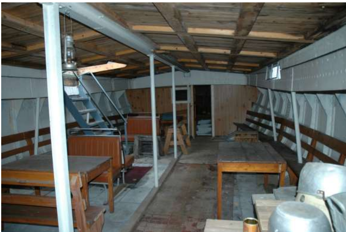
Lasterom ved befaring i 2013. Roar Sundt hadde opprinnelig planer om å ta med passasjerer/serveringstilbud og satte inn bl.a buss-seter og bord. Mot maskinskottet tenkte han lage en liten kjøkkenkrok. Benkene langs skipssiden fikk han fra Tryggheim (bedehus i Gran). Alt av inventar på bildet, samt kledning på skottet inn mot lugar og betonghellene er anskaffet og plassert av Sundt. Døren inn til lugaren og vinduet har vi restaurert og gjenbrukt. Døren er en kopi som Roar fikk laget på Blekkerud snekkerverksted, den er basert på restene etter døren som stod i restene av skottet i 1979.
