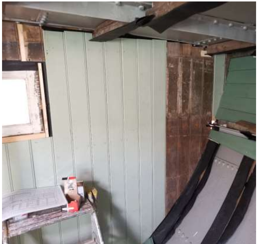
Stenderverk tverrskott i kjerneved av furu. Under t.h.: Fra lugarside. Enkelte felt med original panel er bevart. Dette er ikke malt over, men beholdt med originalslitasje.
