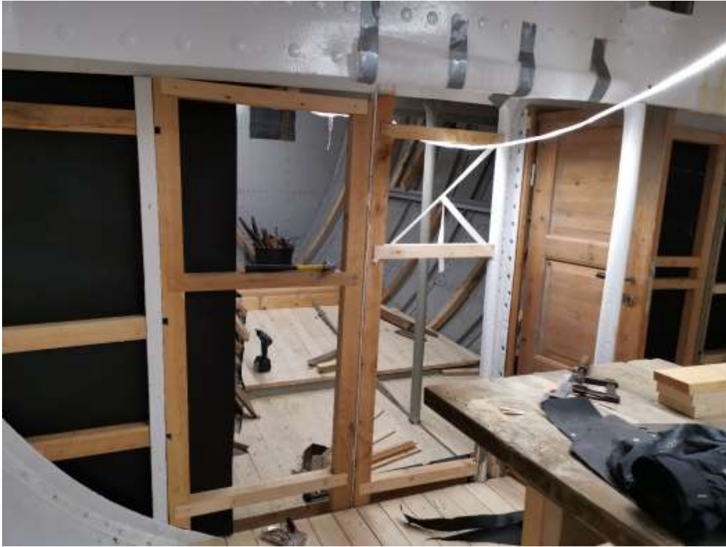
Stenderverk tverrskott i kjerneved av furu. Under t.h.: Fra lugarside. Enkelte felt med original panel er bevart. Dette er ikke malt over, men beholdt med originalslitasje.
