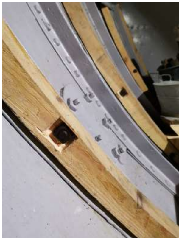
Rekonstruert spant/spikerslag boltet fast med originalbolt. Spantene er i kjerneved av furu og tilpasset for hånd etter kopi av de originale. Under: kopiering av spikerslag
