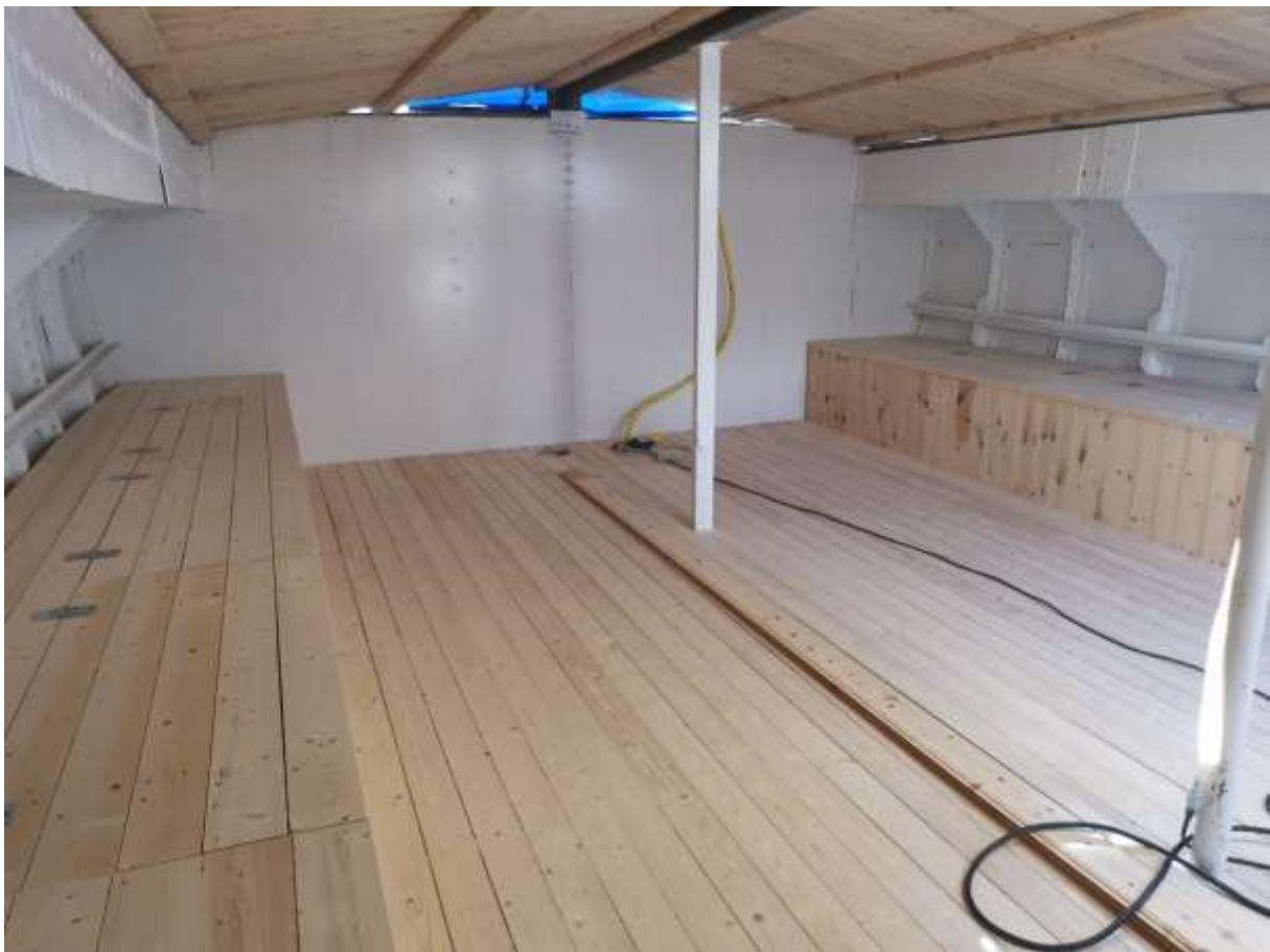
Lasterom, 9.mars. Kun overflatebehandling gjenstår. I enden inn mot maskinskottet sees lensebrønnene. Her kan dørkeplaten løftes vekk ved behov. Det er støpt ballast som har hellning akterover til brønn. Dørken ligger med lufting (lektet opp) over ballast, og slik at den ikke blir utsatt ved mindre vanninntrengning. I kassene er det ikke lagt bunn, slik at man vil kunne se om det er fukt eller ligger vann på ballasten.
