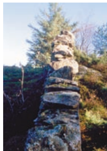
I ein enkeltmur legg ein steinane oppå einannan med dei største steinane underst. Dei eldre steinmurane er bygde av rundare steinar som ikkje er større enn at dei kunne berast bort frå åkrane.
