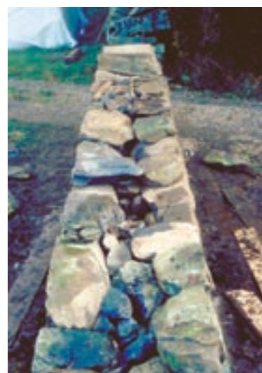
I ein dobbeltmura steingard skal tyngdepunktet i muren gå inn frå sidene og ned i muren. Dette oppnår ein ved å leggja steinane med litt fall innover mot midten i muren. Dei små steinane er innfyll som gjer muren meir stabil.
