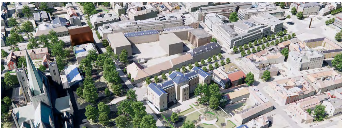
6 etasjes bygg mellom TKM og Ni Muser, ca 3 800m 2 BTA.
