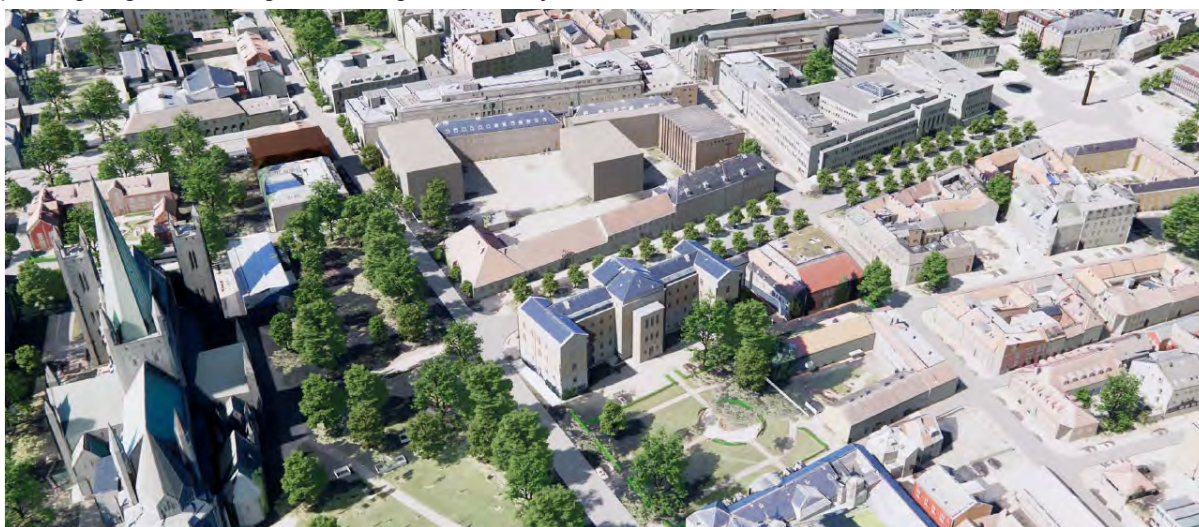
4 etasjes bygg mellom TKM og Ni Muser, ca 2 200m 2 BTA.
