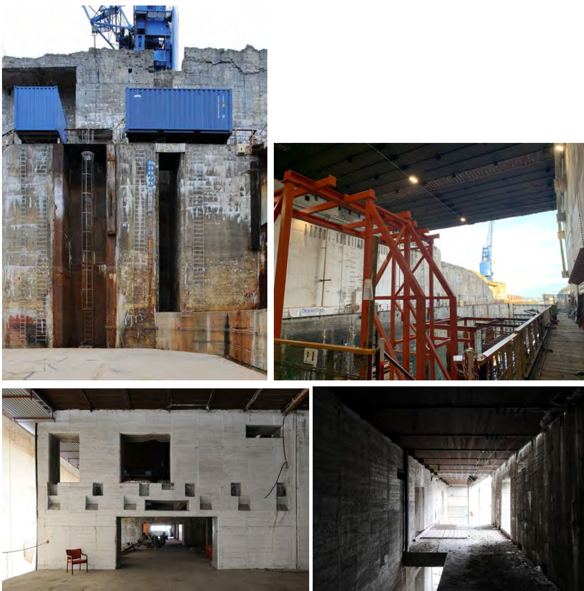
Foto av dagens situasjon, ute øverst til venstre, og inne med vann inn i dokk øverst til høyre. Interiørbilder nederst.
