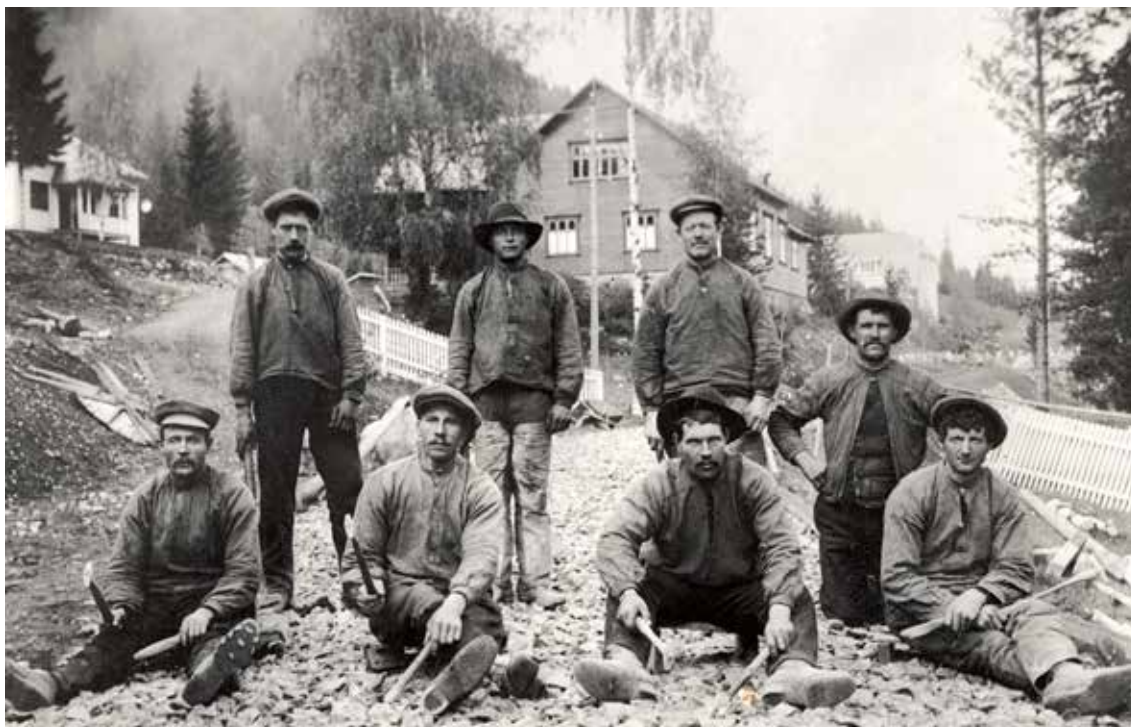
Bygging og vedlikehold av chausséene krevde flere og mer spesialiserte arbeidere enn de eldre vegene, og i veiloven av 1912 var det forutsatt at det normalt skulle benyttes leiet arbeidshjælp og ikke lenger naturalarbeid, også til vedlikeholdet. Det var tungt, manuelt arbeid det var snakk om – her ser vi vegarbeidere på Fagernes i gang med manuell pukking rundt 1912.
