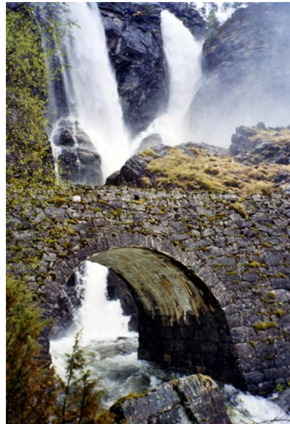
Hesjedalsfossen bru fotografert i samband med registreringa til verneplanen i 1998. (Foto: Jan Adriansen)
