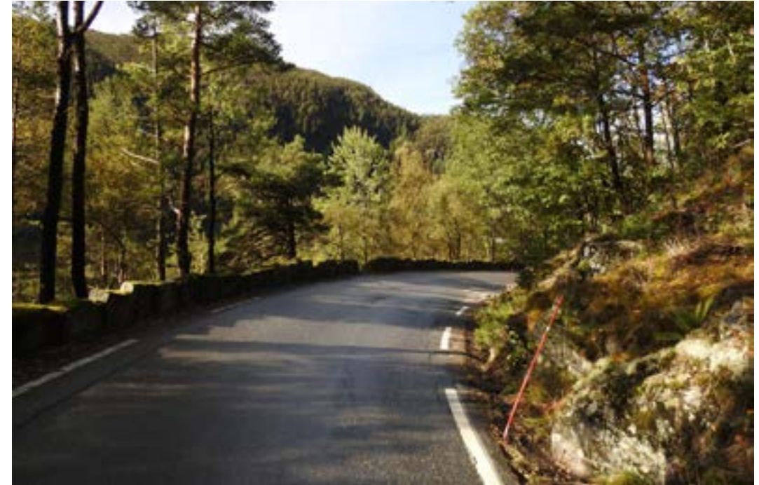
Den karakteristiske muren mot sjøen er noko av det som gjer denne vegen spesiell: Den er avgrensa med tørrmur mot sjøen på lange strekkjer; kanskje på 70-80 % av veglengda. Her ved Vårneset, mellom Straume og Stamnes. (Foto: Kåre Olav Aldal)
