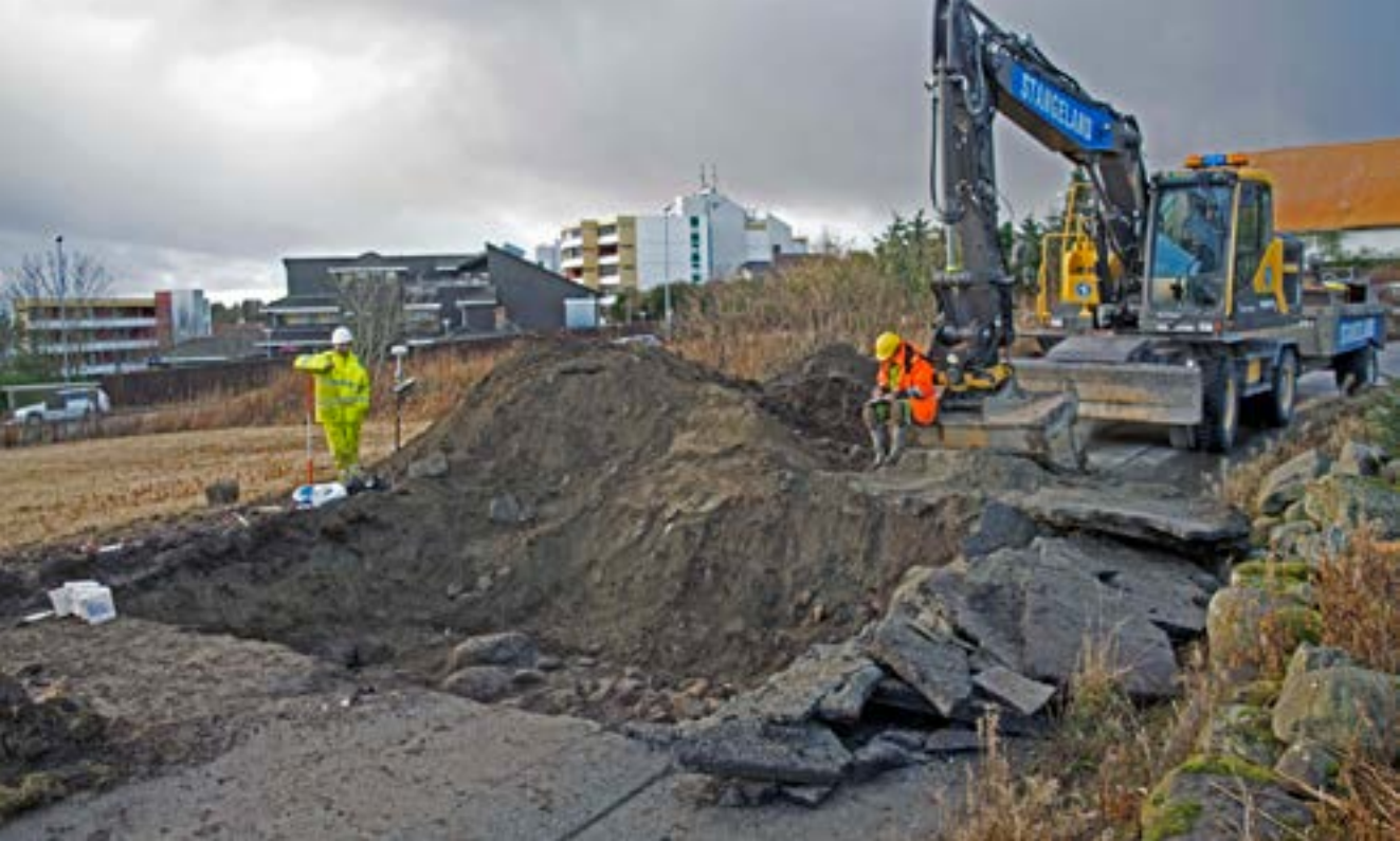
Figur 8: Sundeveien 2015. Sjakt 1 under utgraving. (Foto: Even Bjørdal, Am UiS)
