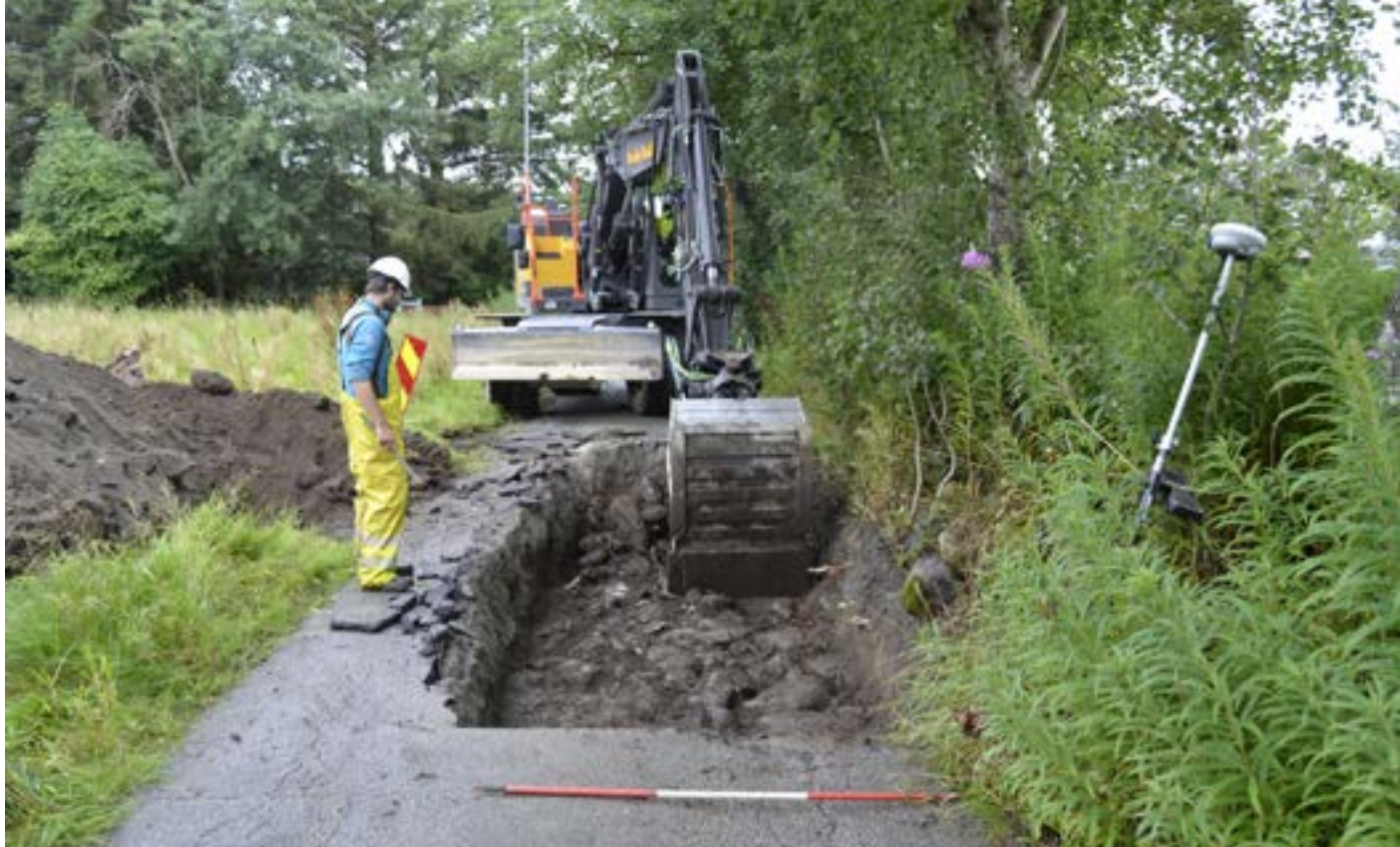
Figur 15: Sundevegen 2017. Sjakt B ved oppstart. (Foto: Even Bjørdal, Am UiS)
