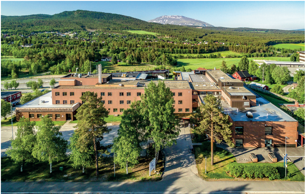
Dronebilde av Tynset sjukehus 2019. Foto: Thorbjørn Liell.
